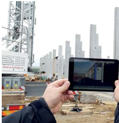
Über Tablets können sämtliche Baufortschritte direkt im BIM-Modell markiert werden.
