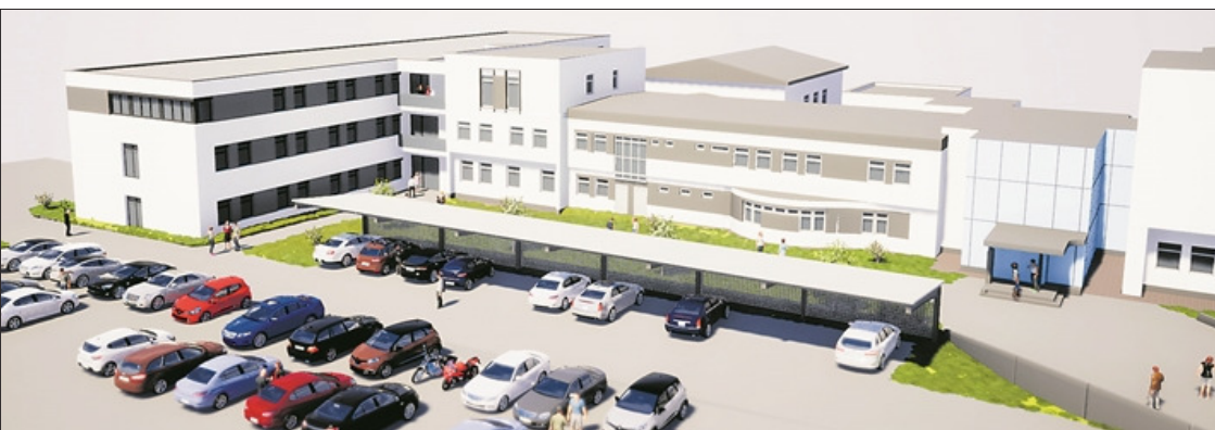
Der Aufwärtstrend schlägt sich bei Leyrer+Graf in zunehmendem Platzbedarf am Firmensitz nieder. Er wird nun mit einem Bürozubau (linke Bildhälfte) und einem „Upgrade“ des Bestandes aufgewertet. Kostenpunkt: 5,5 Mio. Euro.
