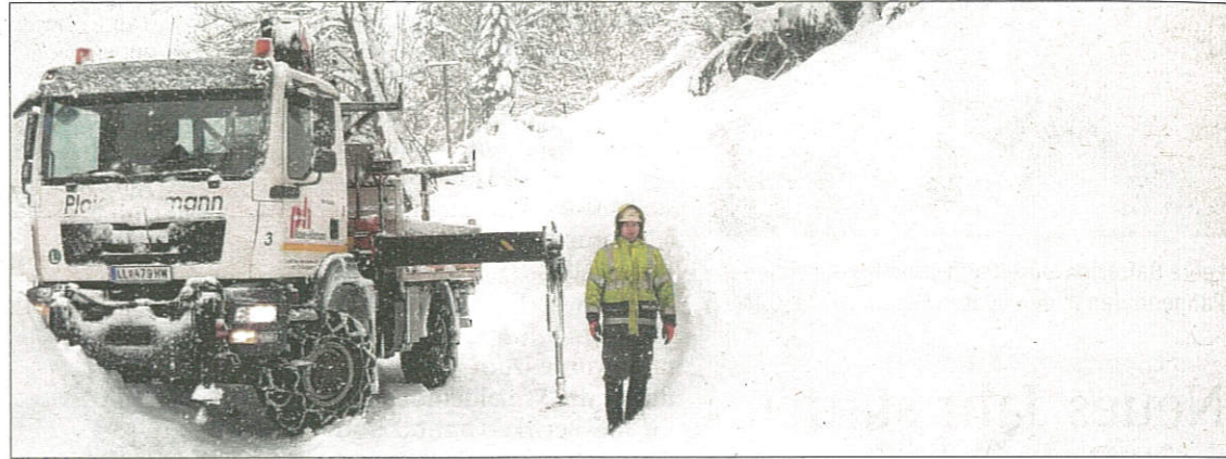
Montageteams der L+G-Tochter Ploier+Hörmann mit Kranwägen zwischen Schneemassen.
