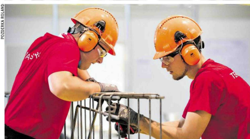
Modul 3 der t-förmige Bewehrungskorb
