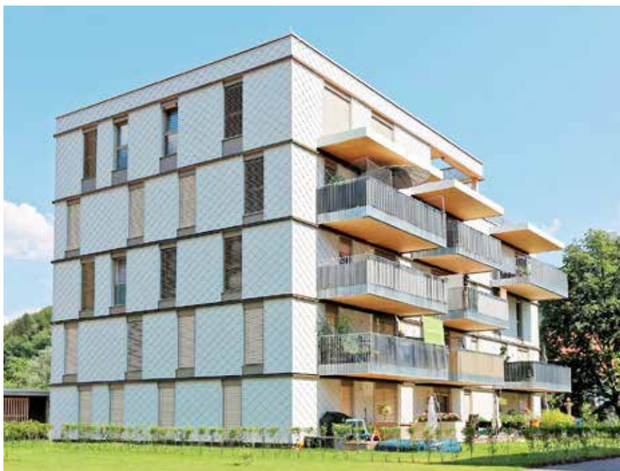
Auch im Wohnbau ist die Graf Holztechnik aktiv, wie hier bei einer Wohnanlage im steirischen Kapfenberg
