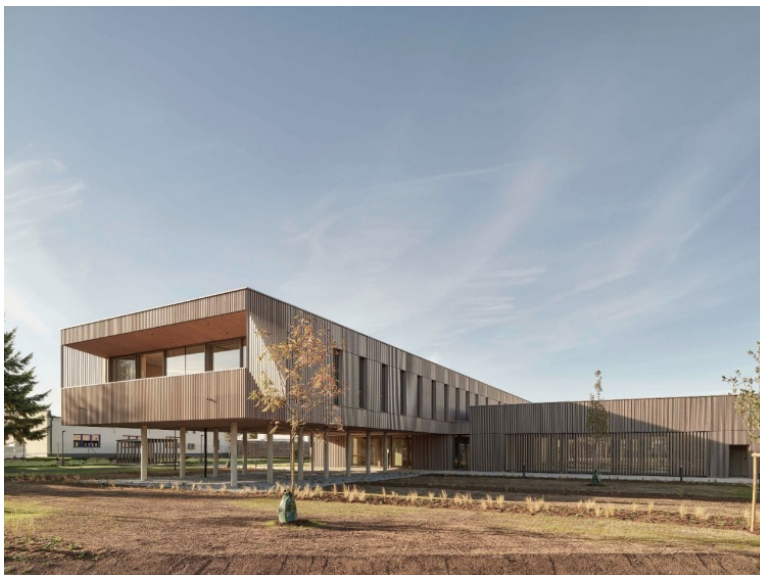
Waldviertel: „Handelshaus Kiennast“ setzte bewusst auf einen Holzbau für den Neubau Seines Bürogebäudes. © Kurt Hörbst
